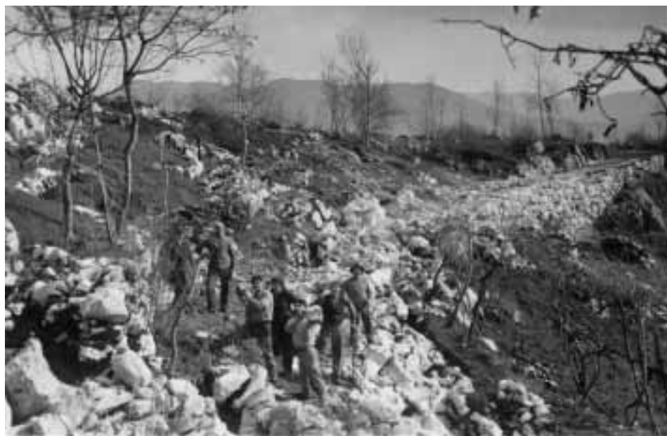
Uomini di Monteprato che costruiscono la strada di Započivàlo /dietro il posto di riposo.
